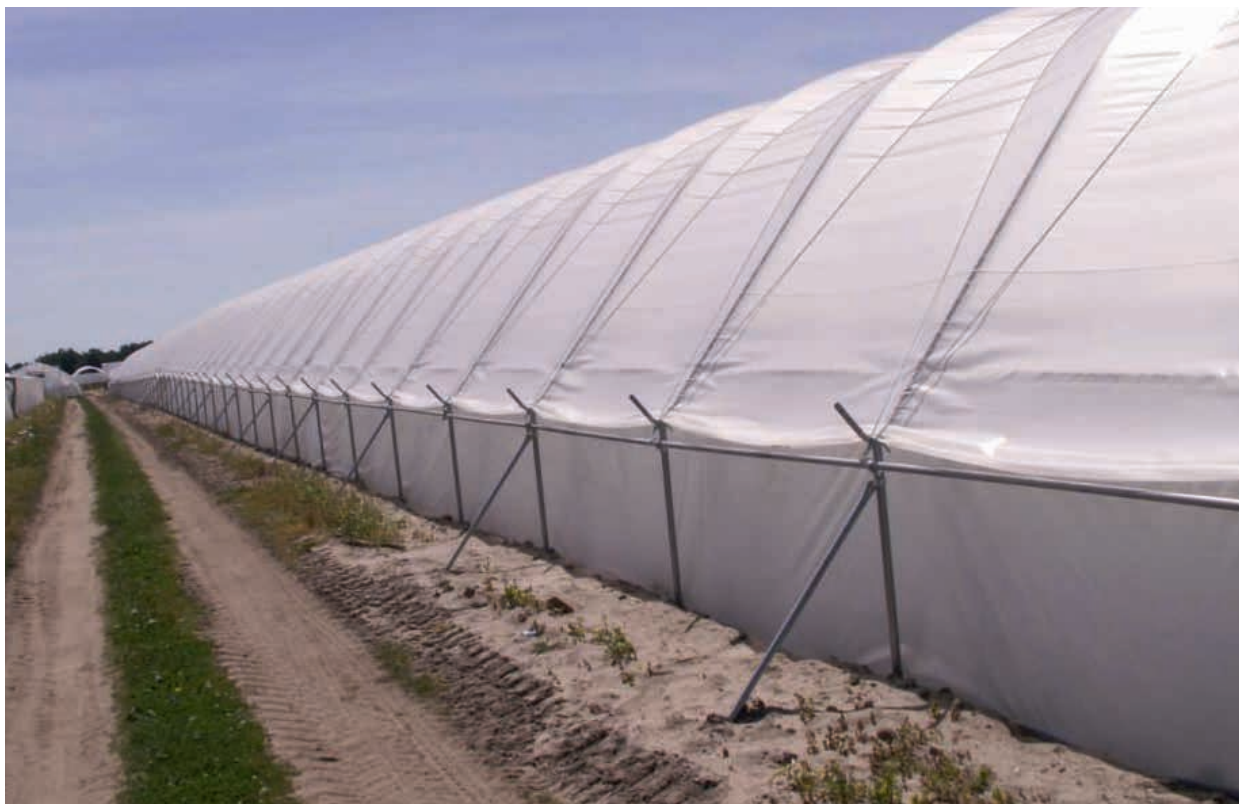
Wzmocnienia boczne tuneli.
